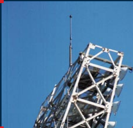
Detalle torre iluminación Vélez Sarsfield
