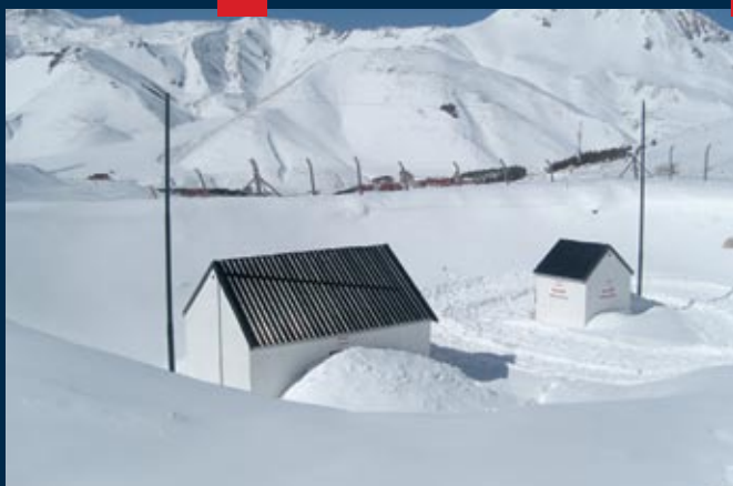
Centro de Esquí Las Leñas (Depósito de explosivos antiavalanchas)
