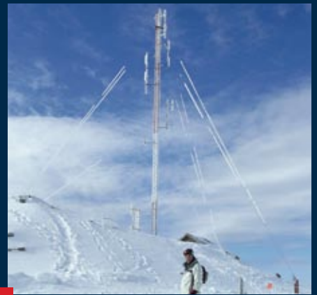
instalación en sistema repetidor a más de 1000 m.
