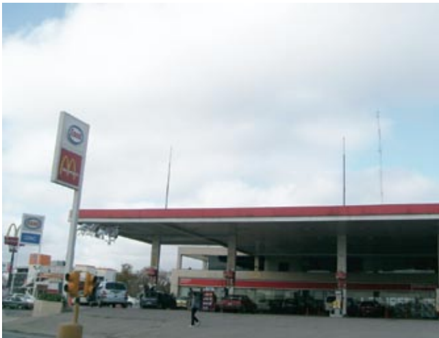
Estación de Servicio GNC y Líquidos ESSO (Pilar)
